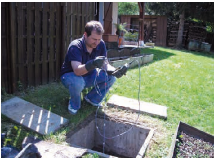
photo A. Guillet, technicien, mesure les boues
